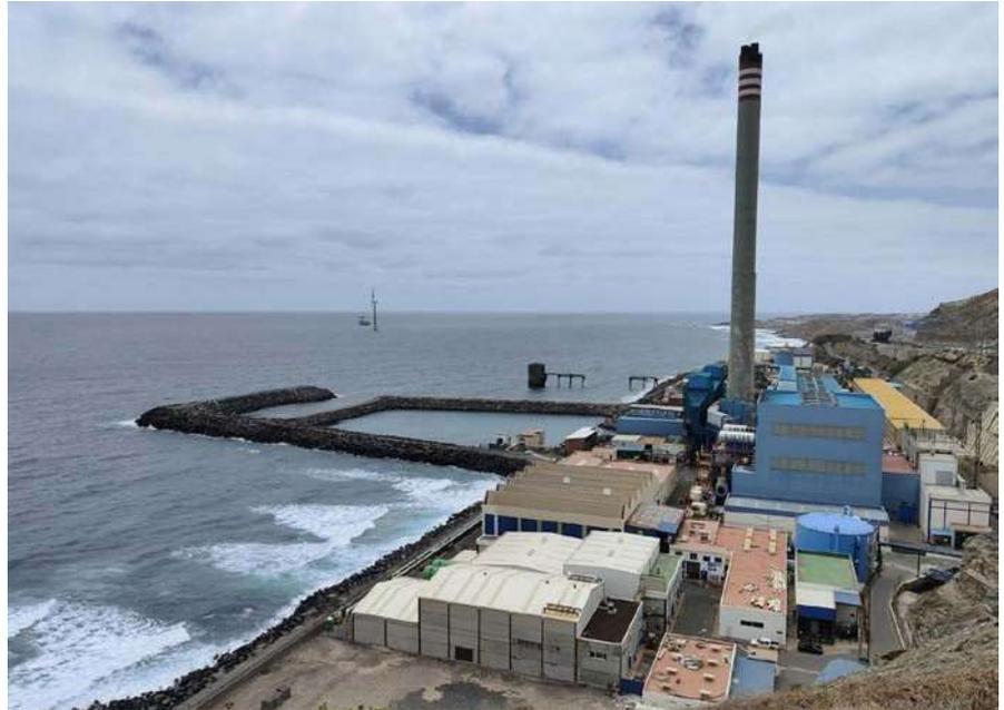
*Immagine 17: Fotografia di un impianto di desalinizzazione con relativa centrale termica sull'isola di Gran Canaria.*
