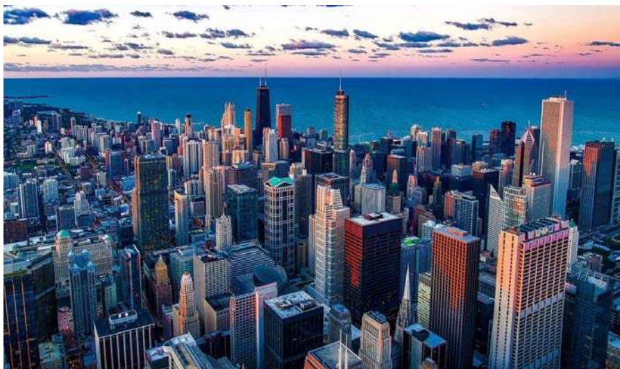
Zdjęcie 10: Wieżowce w Chicago zbudowane na stalowych ramach.
