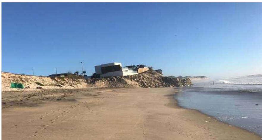
Rysunki 44 i 45: Przykłady ochrony nadmorskich budynków mieszkalnych w Portugalii dotkniętych zanikiem wydm w kontekście podnoszenia się poziomu morza.
