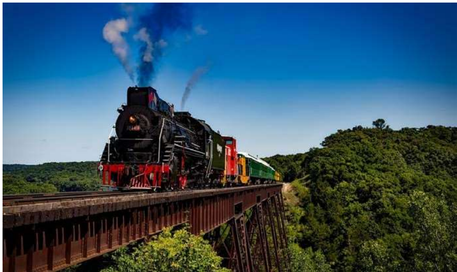
Zdjęcie 9: Fotografia starej linii kolejowej przechodzącej przez stalowy most.
