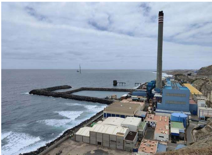
Zdjęcie 17: Zdjęcie zakładu odsalania z elektrociepłownią na wyspie Gran Canaria.
