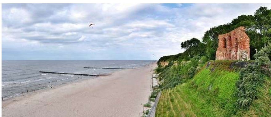
Zdjęcie 48: Trzęsacz (północno-zachodnia Polska) na wybrzeżu Morza Bałtyckiego. Widoczne są ruiny kościoła zbudowanego na początku XVI wieku, który został zniszczony przez nadciągające morze.
