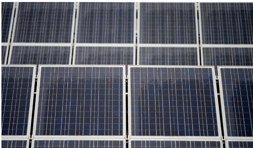
Imagen 97: Placas fotovoltaicas de silicio.
